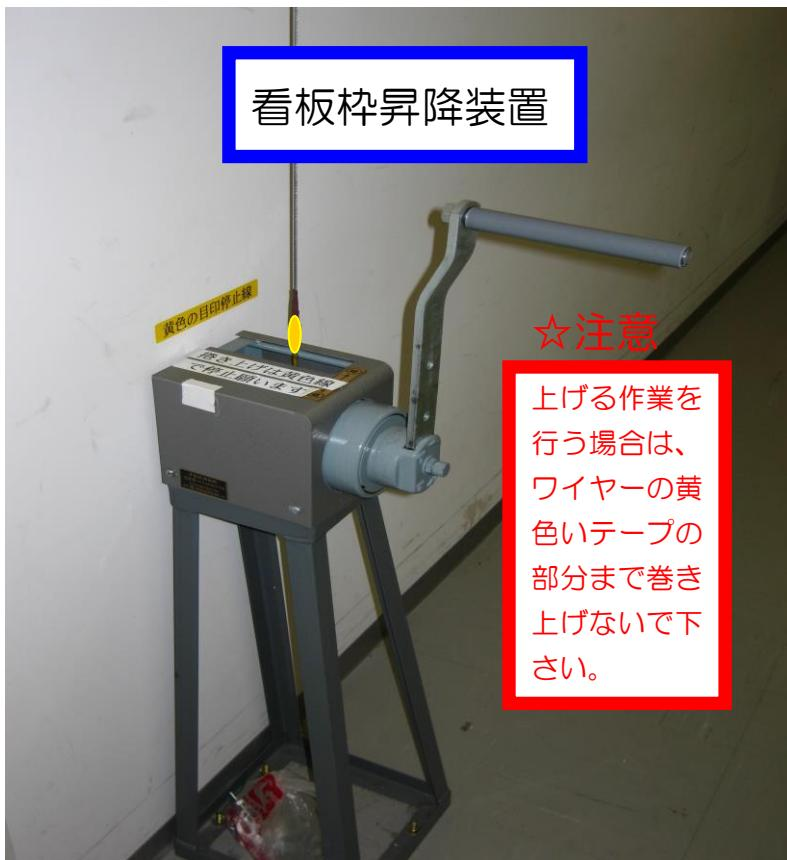
看板枠昇降装置は、設備操作卓側よりステージ裏通路に入ると、左側にあります。左側に廻すと看板枠が降りてきますし、右側に廻すと上がっていきます。看板の昇降作業を行う場合は、ステージに安全確認の方を必ず配置し、声を掛け合いながら作業して下さい。
